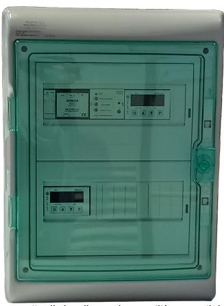
**Q2DTXX** è un quadro che permette di visualizzare le quantità presenti dei gas da monitorare nell'ambiente tramite due detector e di segnalare tramite allarmi acustici/luminosi delle soglie impostate.
